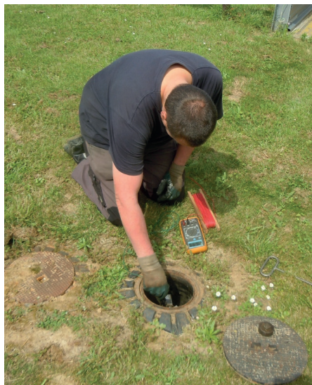
Tweejaarlijkse controle van onze tankinstallatie door ATK
