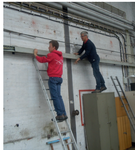
Roel en Yves bij het terugplaatsen van de dekplaten, na onze elektrische inspectie
